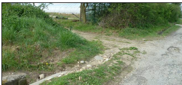
Chemin de la Tuilerie, Taluyers
