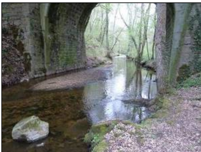
Passage du Garon sous la route du Corrandin, Chaponost
