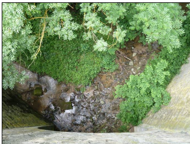
Passage du Furon sous la RD30, Soucieu-en-Jarrest
