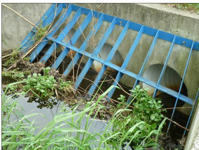
Passage du Bresselon sous la rue des anciens combattants, Montagny
