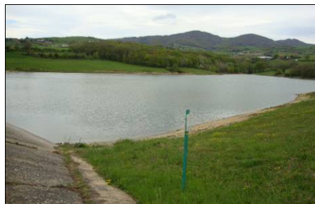
Barrage de la Madone, Mornant
