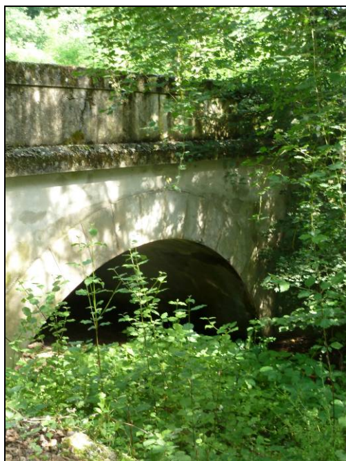
Passage du Merdanson d'Orliénas sous le chemin de Félin, Orliénas
